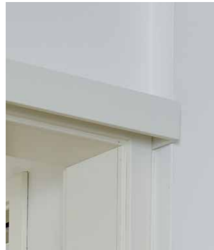
KLASSIK ohne Anschlagkasten mit Türfutter
